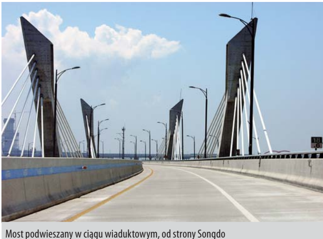
Most podwieszany w ciągu wiaduktowym, od strony Songdo
