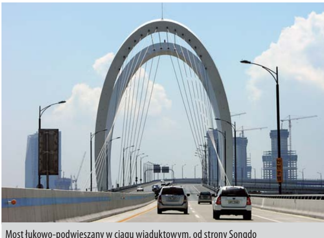
Most łukowo-podwieszany w ciągu wiaduktowym, od strony Songdo
