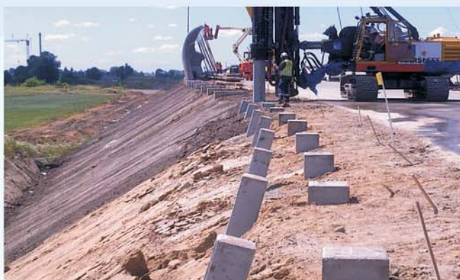
Autostradowa Obwodnica Wrocławia - budowa ekranów akustycznych
