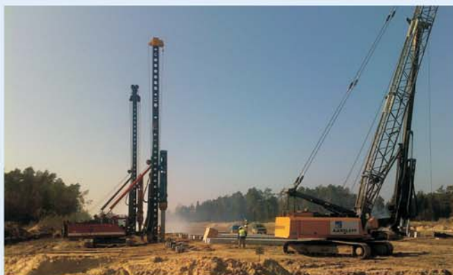
Autostrada A4 - odcinek Rzeszów - Dębica
