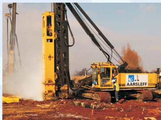
Południowa Obwodnica Gdańska - pale prefabrykowane wbijane pod fundamenty najdłuższej estakady w Polsce
