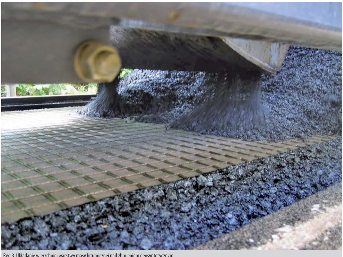
Ryc. 3. Układanie wierzchniej warstwy masy bitumicznej nad zbrojeniem geosyntetycznym
