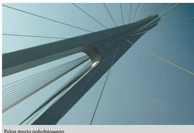
Pylon mostu południowego
