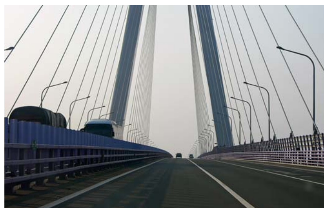
Pomiędzy pylonami mostu północnego
