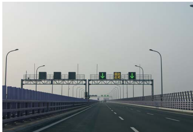
Wiadukt północny w stronę Szanghaju
