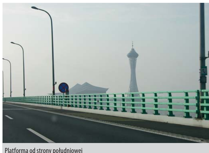
Platforma od strony południowej
