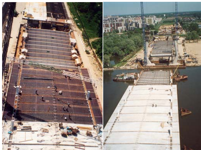
Ryc. 2. Stanowisko scalania konstrukcji stalowej, odcinek przeznaczony do betonowania płyty oraz część zabetonowanej i już przesuniętej konstrukcji
