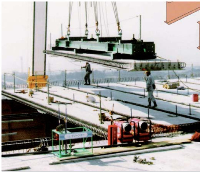
Ryc. 5. Budowa mostu w Japonii z zastosowaniem prefabrykowanych płyt pomostu [4]
