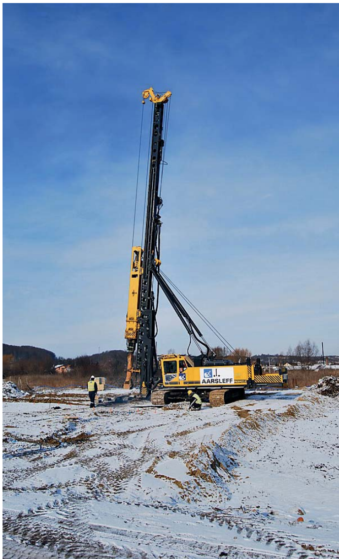
Ryc. 5. Instalacja pali prefabrykowanych
