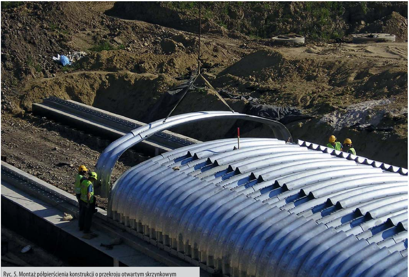
Ryc. 5. Montaż półpiersi konstrukcji o przekroju otwartym skrzynkowym
