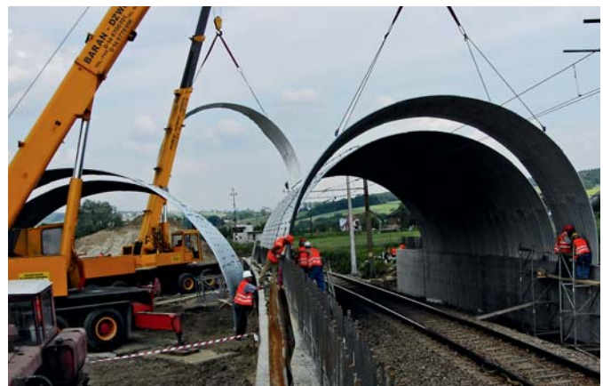
Ryc. 7. Łączenie segmentów konstrukcji w miejscu wbudowania
