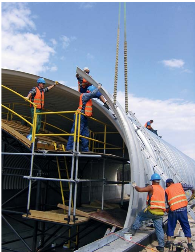
Ryc. 1. Montaż blach bocznych bez prefabrykacji
