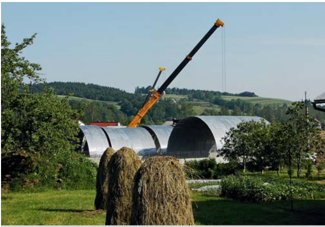
Ryc. 6b. Prefabrykacja segmentów konstrukcji
