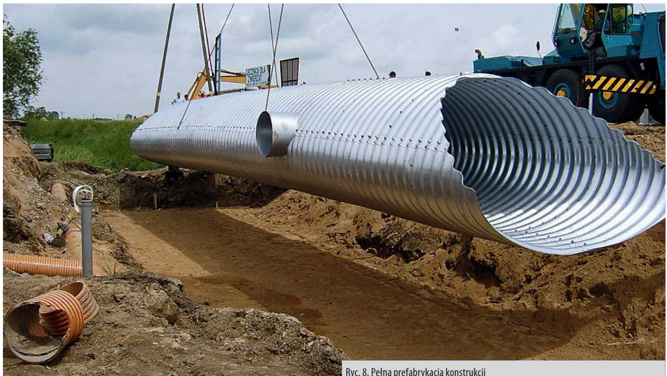
Ryc. 8. Pełna prefabrykacja konstrukcji
