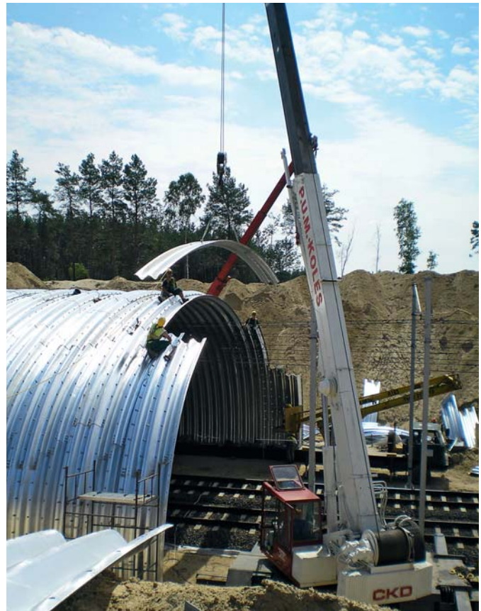
Ryc. 2. Montaż blach górnych bez prefabrykacji
