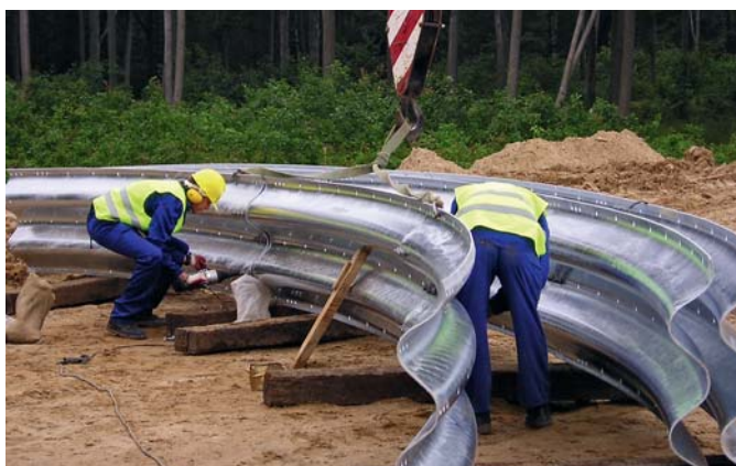
Ryc. 3. Prefabrykacja półpręci
