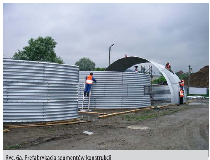
Ryc. 6a. Prefabrykacja segmentów konstrukcji
