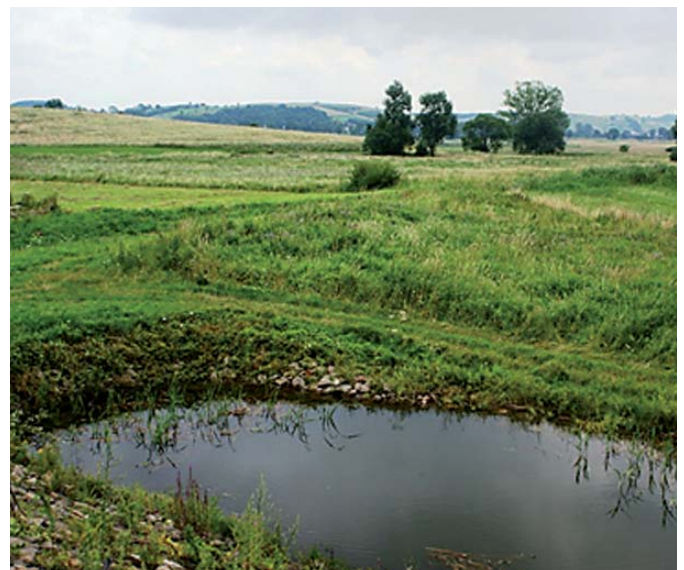
Zbiornik wód deszczowych w miejscowości Klimkówka k. Rymanowa, fot. D. Słyś
