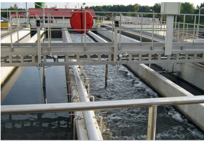
Nowa oczyszczalnia ścieków „Halemba Centrum”
