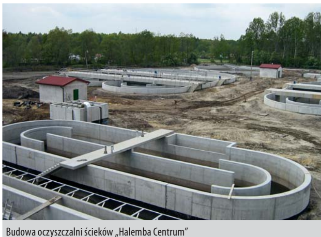
Budowa oczyszczalni ścieków „Halemba Centrum”
