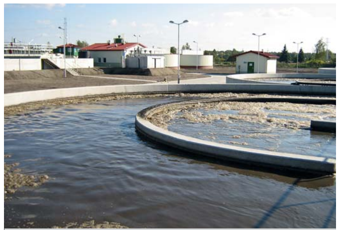
Nowa oczyszczalnia ścieków „Halemba Centrum”
