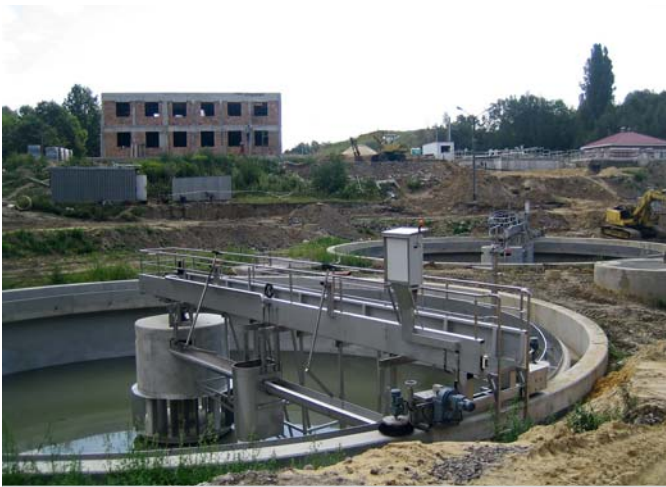
Modernizacja oczyszczalni ścieków „Orzegów”
