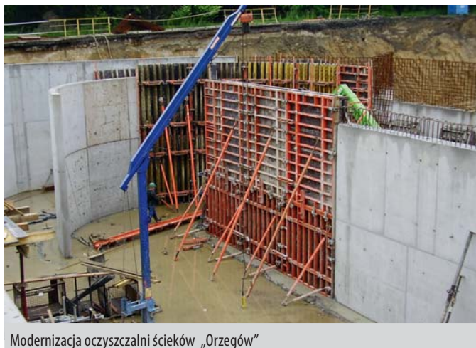
Modernizacja oczyszczalni ścieków „Orzegów”
