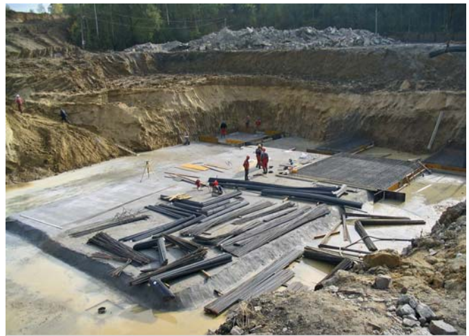
Modernizacja oczyszczalni ścieków „Orzegów”
