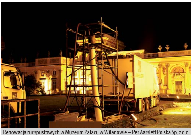
Renowacja rur spustowych w Muzeum Pałacu w Wilanowie – Per Aarsleff Polska Sp. z o.o.
