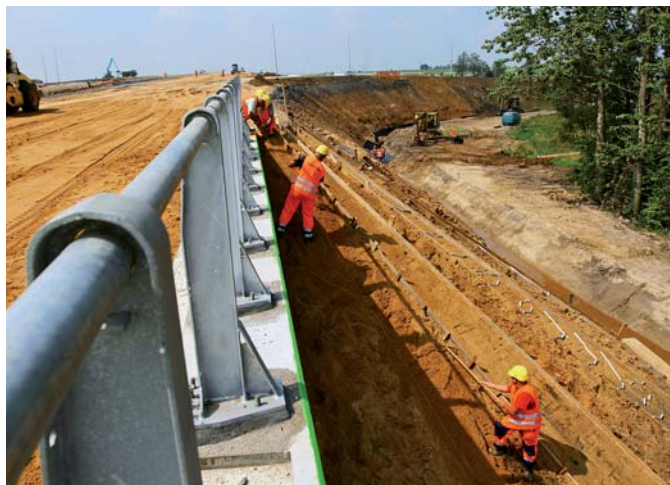
Obiekt mostowy C1.3, prace przygotowawcze przed betonowaniem stożków, sierpień 2010 r., fot. P. Kułaga
