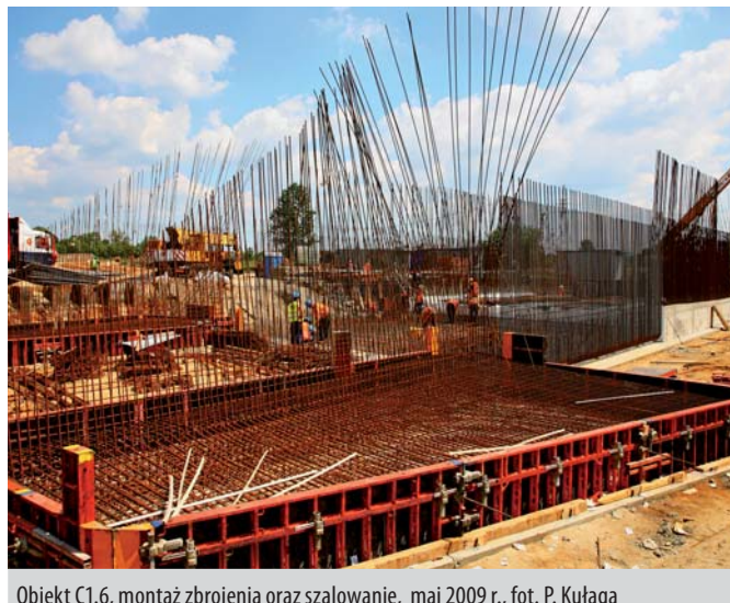
Obiekt C1.6, montaż zbrojenia oraz szalowanie, maj 2009 r., fot. P. Kułaga
