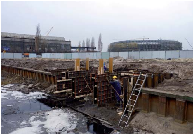
Budowa wlotu kanału „Warzywód III” do zbiornika Uczniowska
