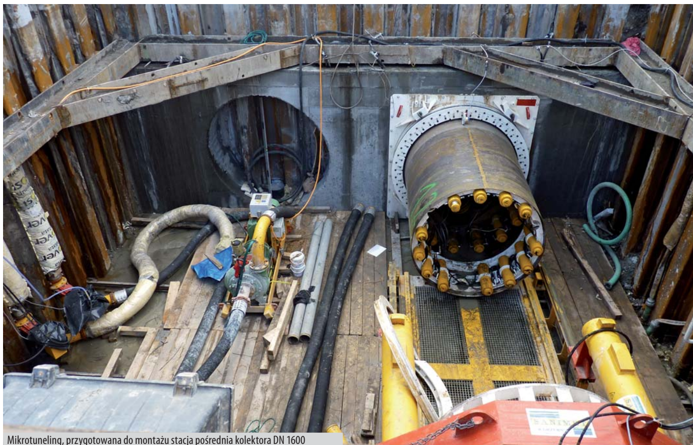
Mikrotuneling, przygotowana do montażu stacja pośrednia kolektora DN 1600
