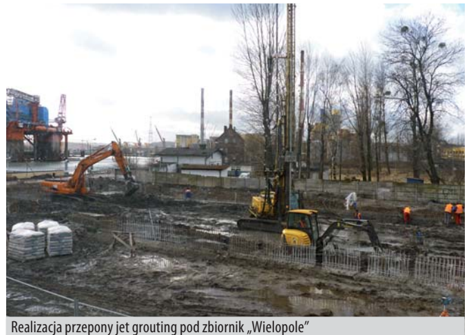
Realizacja przepony jet grouting pod zbiornik „Wielopole”
