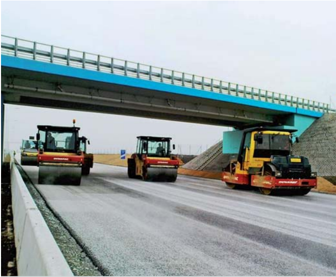
AOW – praca zespołu bitumicznego, Warstwa ścieralna z SMA, fot. J. Stelmaszek/Egis Poland
