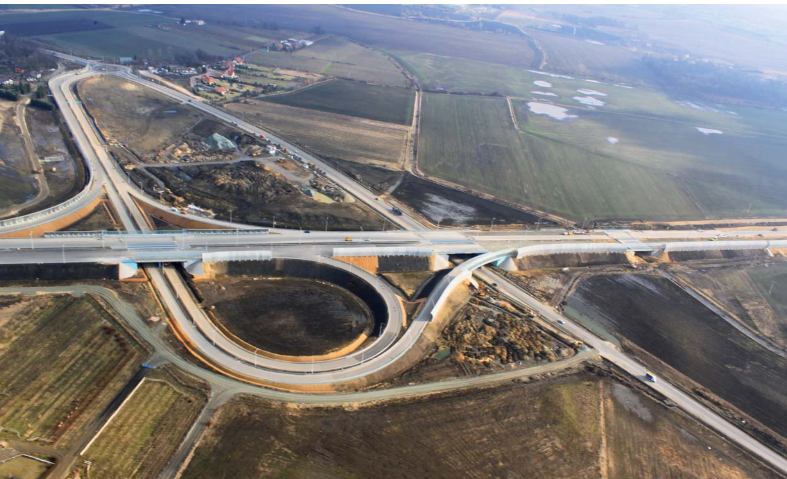
AOW – węzeł Ceszów, fot. W. Kluczewski/Egis Poland
