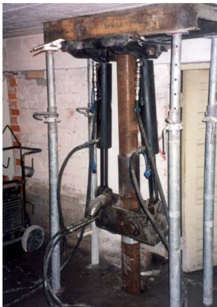
Ryc. 7. Przykłady rozwiązań połączenia mikropali ze wzmacnianą konstrukcją
