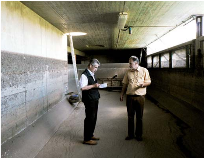
Ryc. 3. Wnętrze komory osadowej z wylotem do komory infiltracyjnej zbiornika z okolic Stuttgartu [8], fot. D. Słyś
