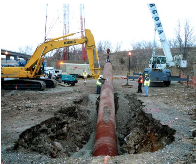
Ryc. 2. Stalowa kolumna rur zapewniająca wykonanie trajektorii przewiertu zgodnie z projektem [6]
