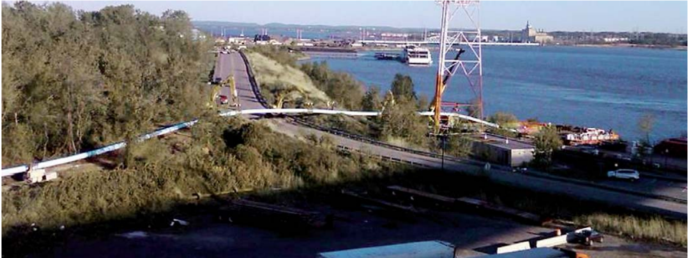
Ryc. 1. Wbudowywanie rurociągu z FPVC metodą HDD pod rzeką Raritan [2]
