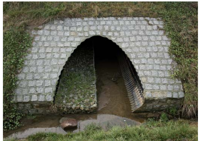
Ryc. 15. Półka wykonana z gabionów bez pokrycia gruntem i bez połączenia z otaczającym terenem (autostrada A1), fot. R. Kurek
