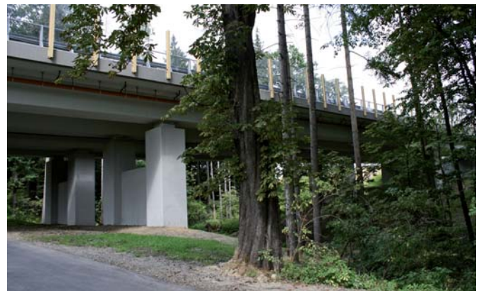
Ryc. 6. Ekran transparentny na dolnym przejściu dla dużych zwierząt (droga ekspresowa S1), fot. R. Kurek
