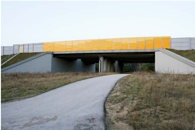
Ryc. 12. Niekorzystne rozwiązanie – droga asfaltowa zlokalizowana na powierzchni przejścia dolnego (autostrada A2), fot. R. Kurek
