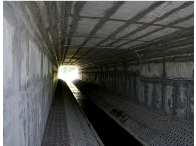
Ryc. 14. Półki ziemne pokryte płytami betonowymi (autostrada A1), fot. R. Kurek
