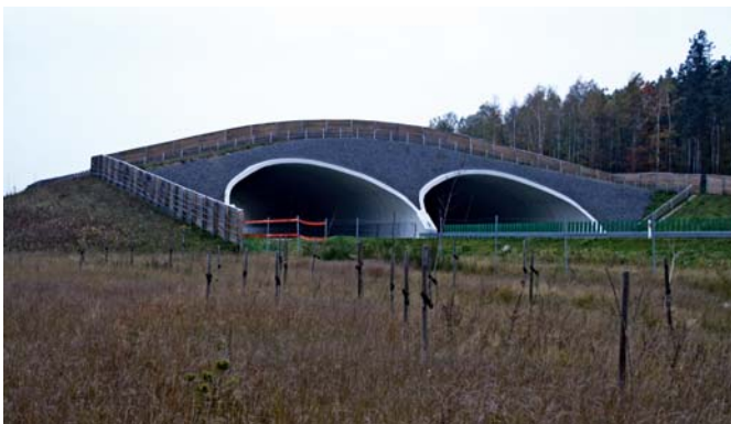
Ryc. 3. Przykład przejścia o zbyt dużym kącie nachylenia najść (autostrada A4), fot. R. Kurek
