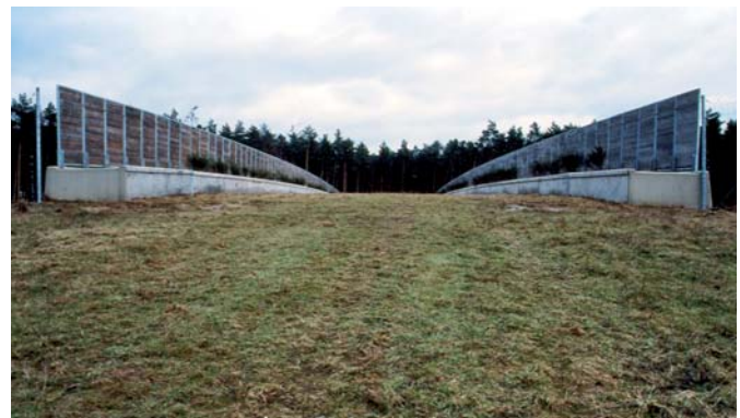
Ryc. 1. Wąskie przejście górne, niedostosowane do wymagań dużych i średnich ssaków (autostrada A4), fot. R. Kurek
