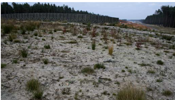
Ryc. 9. Grunt niedostosowany do wymagań roślinności na powierzchni przejścia górnego (autostrada A4), fot. R. Kurek
