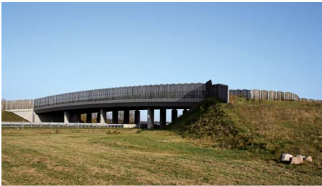
Ryc. 2. Przejście o zbyt małym kącie rozwarcia najść oraz konstrukcji bez zmiennej szerokości (autostrada A2), fot. R. Kurek
