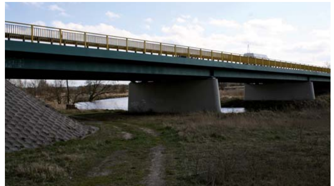
Ryc. 5. Podpory o konstrukcji ograniczającej dostęp światła do powierzchni przejścia (droga krajowa nr 11), fot. R. Kurek
