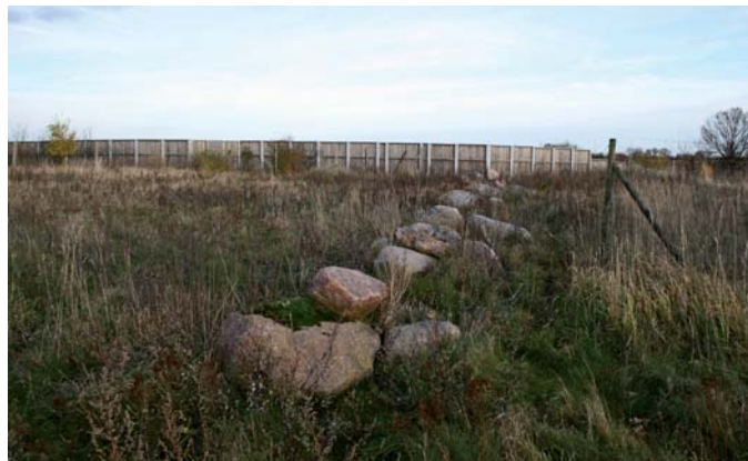
Ryc. 11. Przykład właściwych zabezpieczeń przed przejazdami z wykorzystaniem głazów (autostrada A20, Niemcy), fot. R. Kurek
