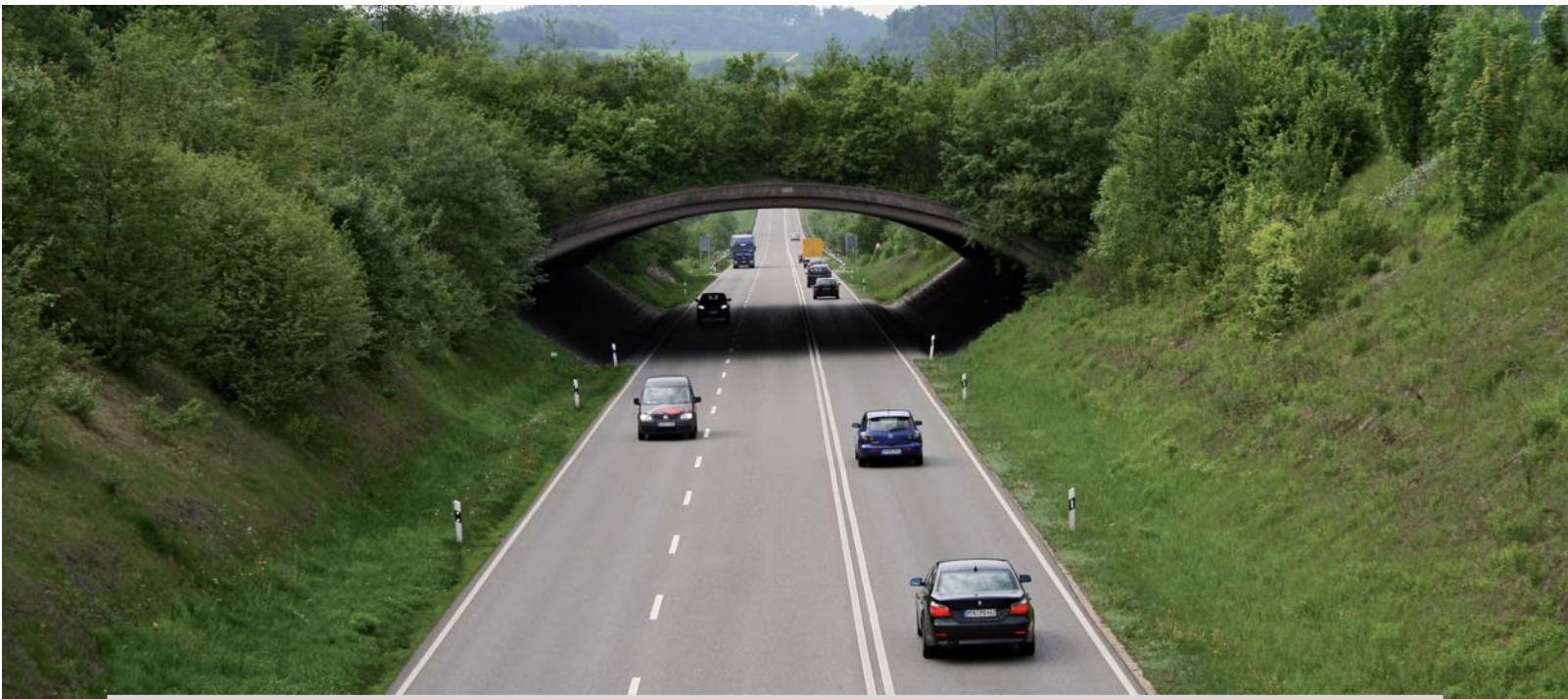
Optymalna lokalizacja przejścia górnego – wykop umożliwiający właściwe wkomponowanie obiektu w otoczenie (droga B31neu, Niemcy), fot. R. Kurek
