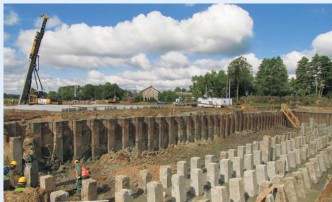
Obwodnica Zambrowa - pale prefabrykowane wbijane
