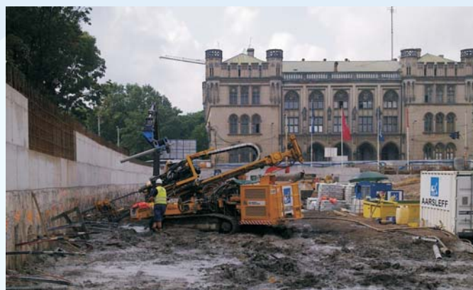
Narodowe Forum Muzyki Wrocław - kotwienie ściany szczelinowej
