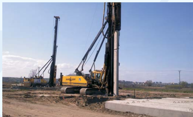
Południowa Obwodnica Gdańska - pale prefabrykowane wbijane pod fundamenty najdłuższej estakady w Polsce
