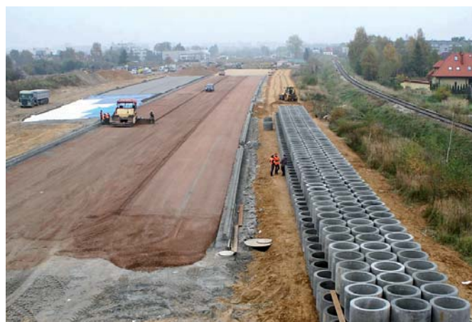
Układanie podbudowy pod nawierzchnie południowej obwodnicy Warszawy
