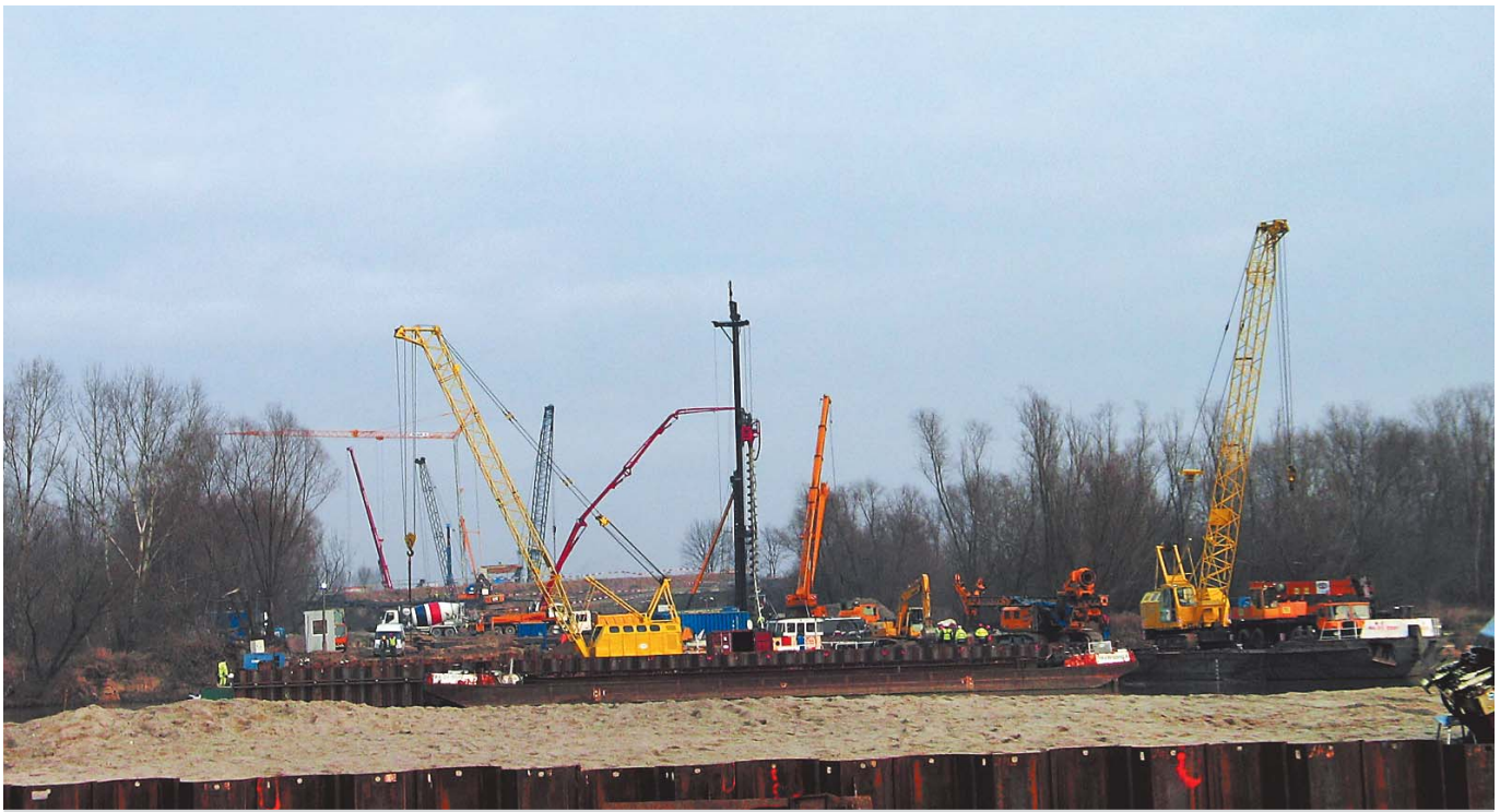
Prace fundamentowe przy podporze nurtowej mostu Północnego w Warszawie
