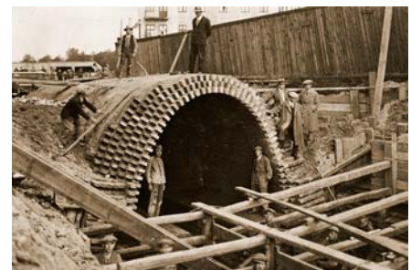
Ryc. 2. Budowa kanału w Łodzi metodą odkrywkową [9]
