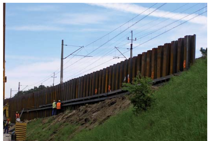
Kotwienie ścianki zabezpieczającej nasyp kolejowy
