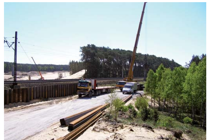
Zabezpieczenie nasypu kolejowego ścianką z grodzic
