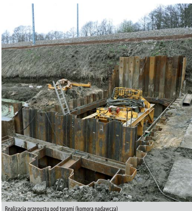
Realizacja przepustu pod torami (komora nadawcza)
