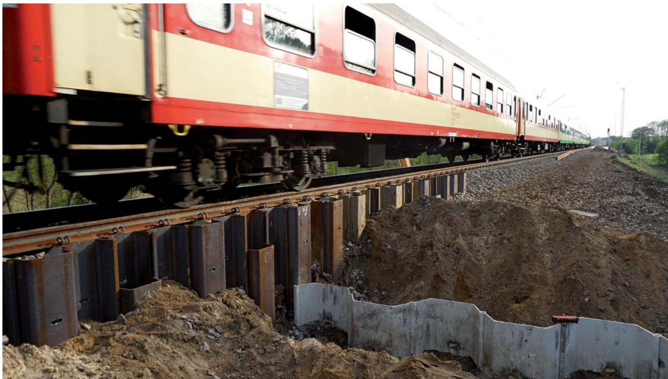
I etap budowy przepustu dla dużych zwierząt (linia kolejowa Warszawa – Łódź)
