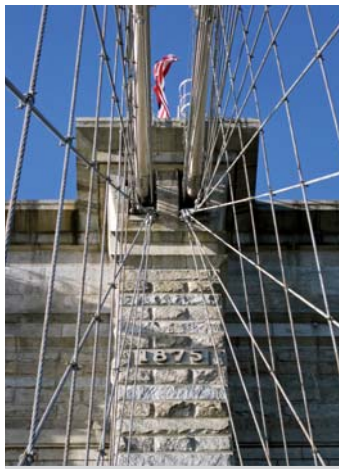
Przejście kabli przez pylon
