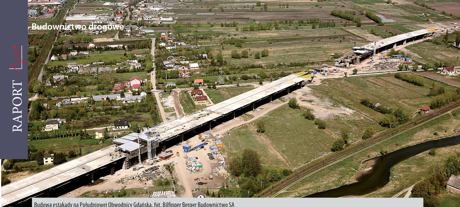
Budowa estakady na Południowej Obwodnicy Gdańska, fot. Bilfinger Berger Budownictwo SA
