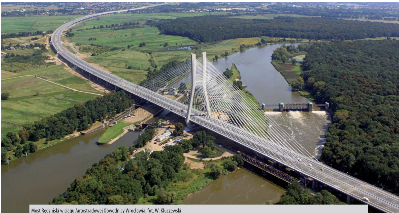
Most Rędziński w ciągu Autostradowej Obwodnicy Wrocławia, fot. W. Kluczewski
