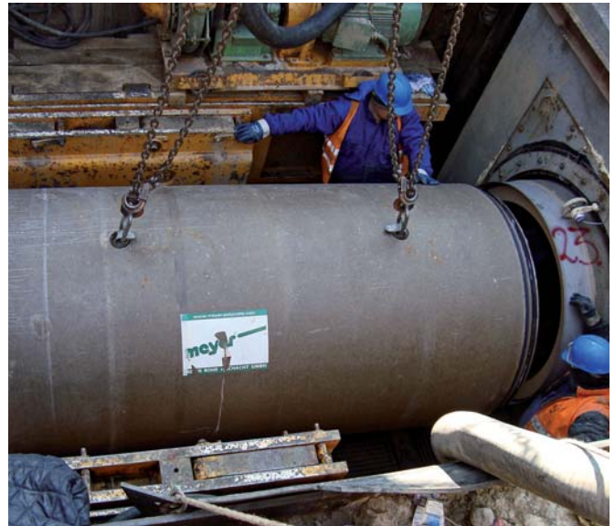
Mikrotunel Meyer DN 1200, Katowice, zlewnia Gigablok, cz. 9, ul. Bochyńskiego
