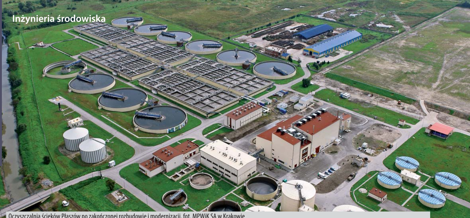
Oczyszczalnia ścieków Płazów po zakończonej rozbudowie i modernizacji, fot. MPWIK SA w Krakowie
