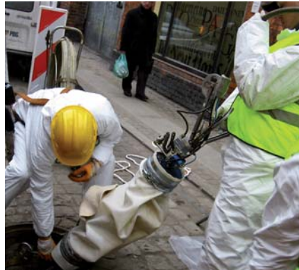
Montaż kształtek kapeluszowych
