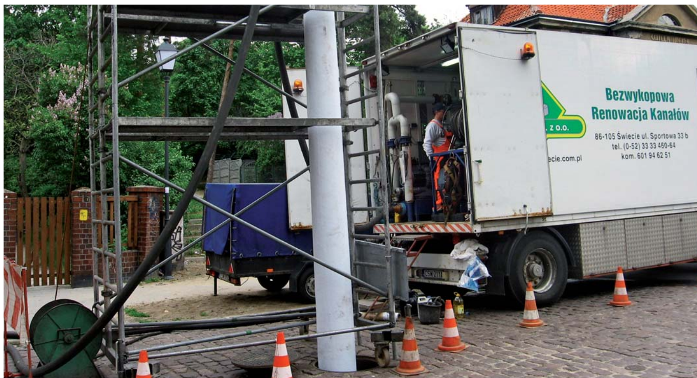
Proces utwardzania wykładziny w kanale
