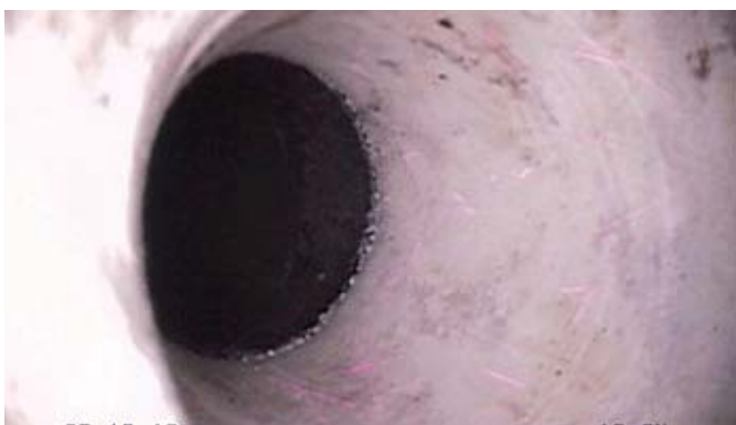
Kanał po wykonaniu renowacji
