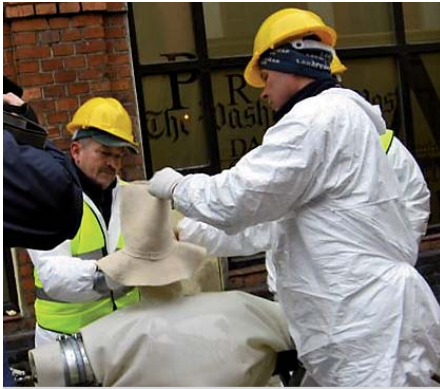
Przygotowanie do montażu kształtek kapeluszowych
