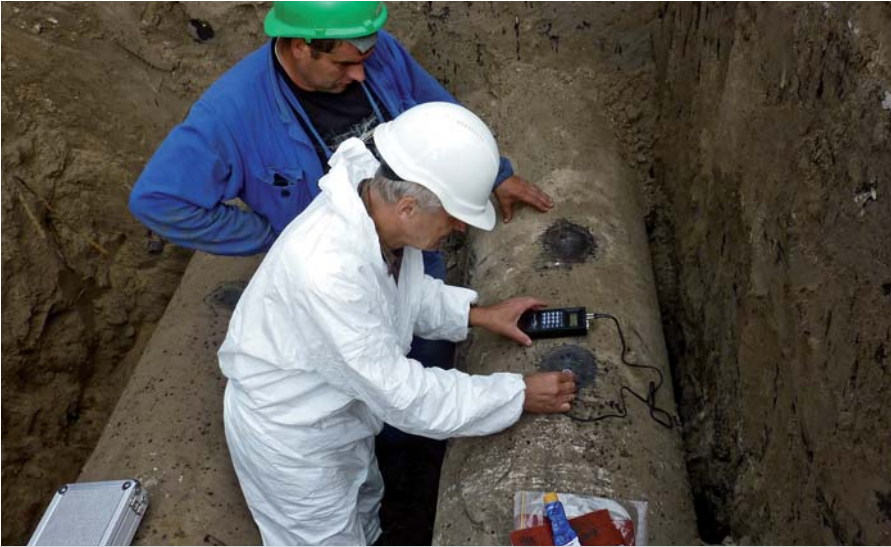
Ryc. 11. Autor opracowania (w białej odzieży roboczej) na stanowisku badawczym w wykopie
