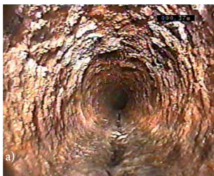
Ryc. 2. Inkrustacja rurociągu żeliwnego (a), widok na ścianę rury z boku (b), fot. A. Kulickowski
