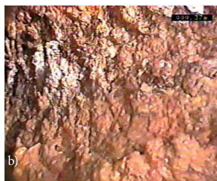
Ryc. 2. Inkrustacja rurociągu żeliwnego (a), widok na ścianę rury z boku (b), fot. A. Kulickowski
