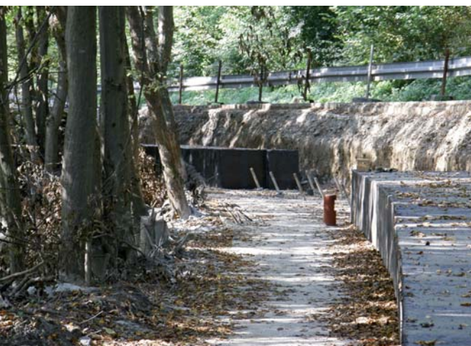
Ryc. 11. Bariera mikropalowa z częściowo wykonanym oczepem
