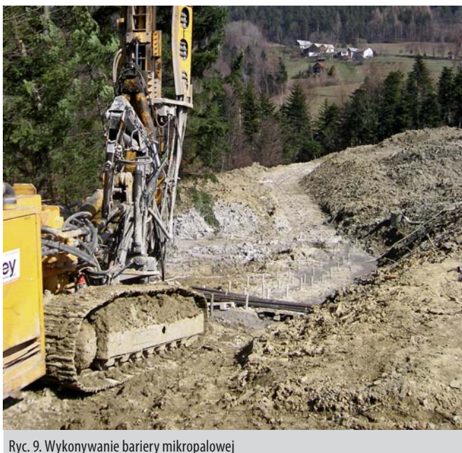
Ryc. 9. Wykonywanie bariery mikropalowej
