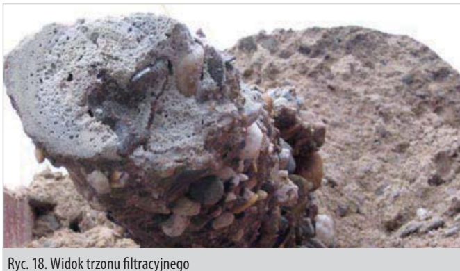
Ryc. 18. Widok trzonu filtracyjnego
