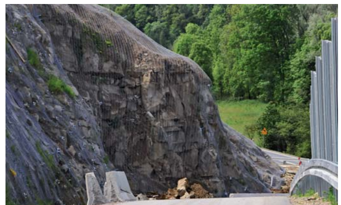
Ryc. 5. Widok zabezpieczonych skarp i urwiska skalnego, Lubień
