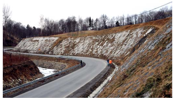
Ryc. 3. Widok zagwoździowanych skarp osuwiskowych z oblicowaniem elastycznym, Szymbark
