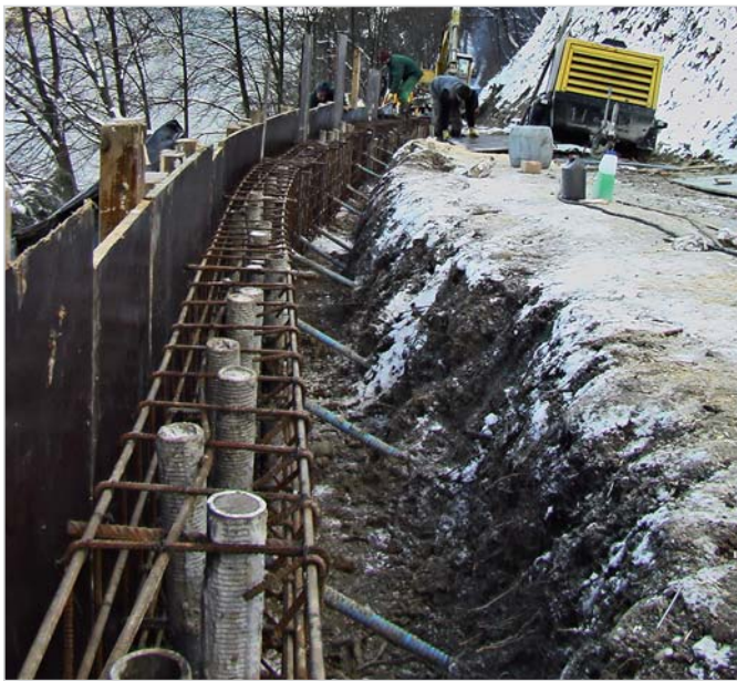
Ryc. 15. Formowanie ściany tesyńskiej
