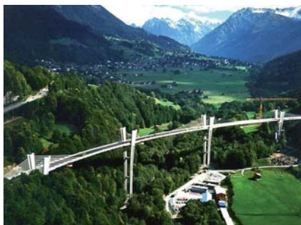
Ryc. 29. Christian Menn, most typu extradosed Sunniberg k. Klosters (1980), l_{\max} = 140,0 m [6]
