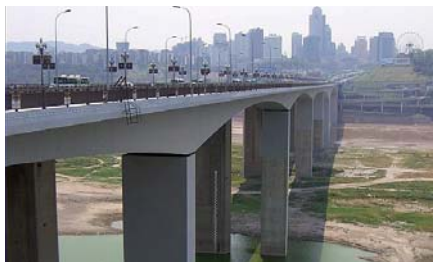
Ryc. 40. Belkowy most Shibano przez Jangcy, Chiny, 2006, l_{\max} = 330,0 m [6]
