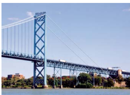
Ryc. 6. Most wiszący Ambassador przez rzekę Detroit na granicy USA – Kanada, 1929, l_{max} = 563,9 m [3]
