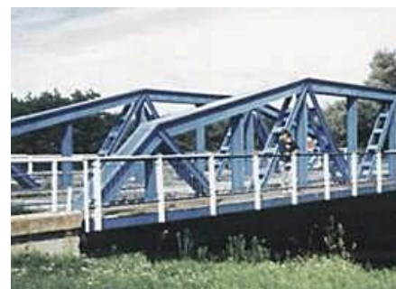
Ryc. 22. Stalowy most spawany na Słudwi pod Łowiczem, 1926–1928, l = 27,0 m [6]
