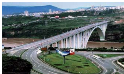
Ryc. 41. Łukowy most betonowy Wanxian przez Jangcy, Chiny, 1997, l_{\max} = 420,0 m [13]
