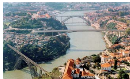
Ryc. 37. António Adão da Fonseca, łukowy most z betonu sprężonego przez Douro w Porto, 2003, l = 280,0 m [10]
