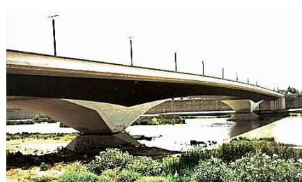
Ryc. 35. Julio Martinez Calzon, most del Arenal o podwójnym zespoleniu przez Guadalquivir w Kordowie, 1993, l_{\max} = 110,0 m [11]
