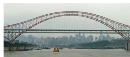
Ryc. 42. Łukowy most stalowy Chaotianmen przez Jangcy, Chiny, 2009, l_{\max} = 552,0 m [13]
