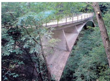
Ryc. 25. Żelbetowy most Schwandbach w Hinterfulingen w Szwajcarii, 1933 [2]
