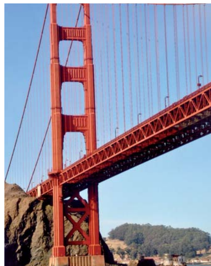
Ryc. 19. Szczegóły mostu Golden Gate [3]
