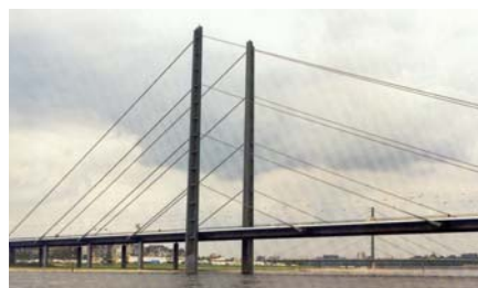
Ryc. 30. Fritz Leonhardt, podwieszony most Kniebrücke przez Ren w Düsseldorfie, 1969, l_{\max} = 320 m [16]
