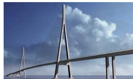
Ryc. 43. Most podwieszony Sutong przez Jangcy, Chiny, 2008, l_{\max} = 1088,0 m [6]
