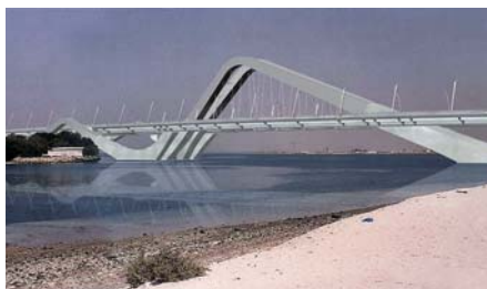
Ryc. 39. Zaha Hadid, łukowy most Szejka Zayeda w Abu Dhabi, 1998–2010, l_{\max} = 150 m [6, 12]
