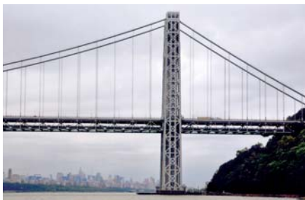
Ryc. 15. Ukształtowanie pylonu Washington Bridge [3]
