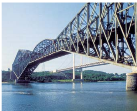
Ryc. 7. Most wspornikowy Quebec na rzece św. Wawrzyńca w Kanadzie, 1917, l_{max} = 548,6 m [7]
