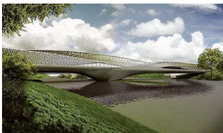
Ryc. 38. Zaha Hadid, most-pawilon przez Ebro, zbudowany na Expo 2008 w Saragossie, 2006–2008, powierzchnia całkowita mostu 6415 m 2 , powierzchnia wystawowa 3915 m 2 [6, 12]
