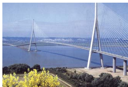
Ryc. 32. Michel Virlogeux, podwieszony most Normandie przez estuarium Sekwany k. Hawru, 1989–1994, l_{\max} = 856,0 m [2]
