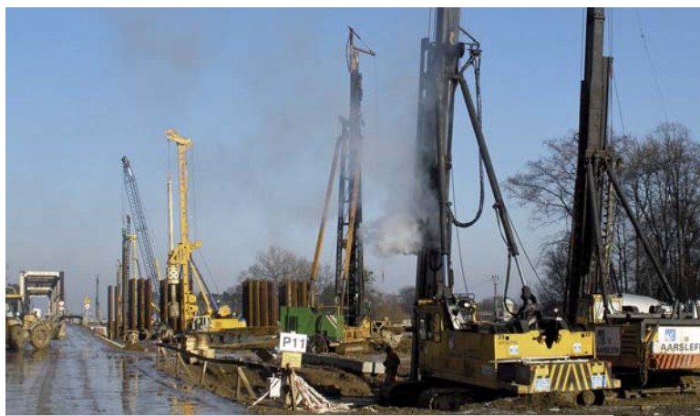
Estakada E1 – roboty palowe pod podpory, fot. B. Kaczmarczyk, Mostostal Warszawa SA
