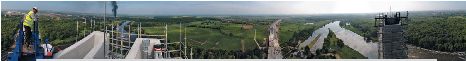
Widok ze szczytu pylonu, fot. B. Kaczmarczyk, Mostostal Warszawa SA
