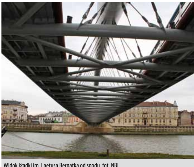
Widok kładki im. Laetusa Bernatka od spodu, fot. NBI
