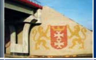
Źródło: Autostrada Wielkopolska SA
