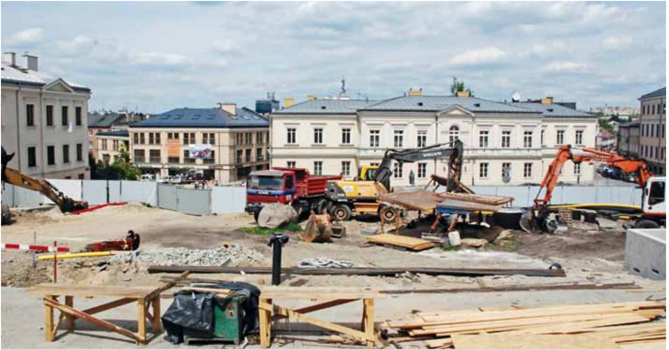
Układanie infrastruktury na kieleckim placu Marii Panny podczas dobiegającej końca rewitalizacji śródmieścia miasta
