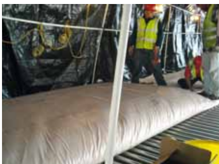
Ryc. 4. Rozprowadzanie żywicy
