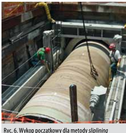
Ryc. 6. Wykop początkowy dla metody sliplining
