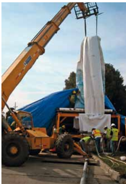
Ryc. 5. Montaż CIPP
