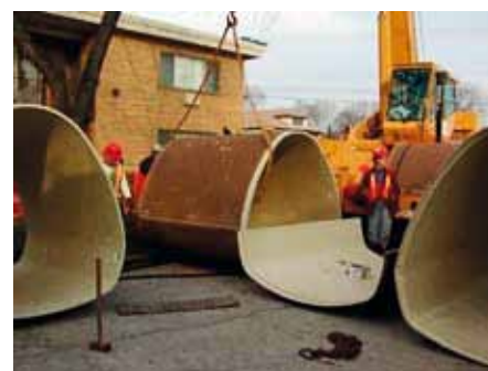
Ryc. 7. Segmenty przygotowane do instalowania
