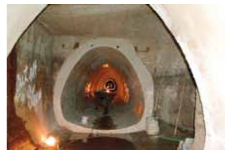
Ryc. 8. Po zainstalowaniu wykładziny
