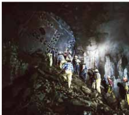
Ryc. 15. Głowica maszyny TBM
