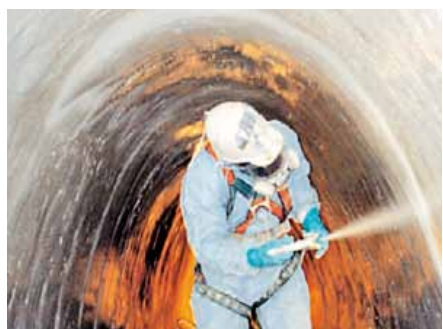
Ryc. 10. Nakładanie drugiej warstwy betonu natryskowego
