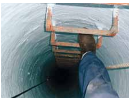
Ryc. 12. Studzienka odnowiona żywicą epoksydową
