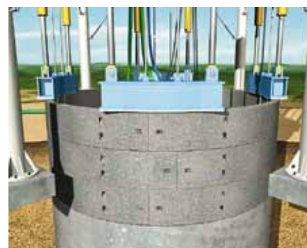
Ryc. 7. Wciskanie w grunt elementów obudowy komory za pomocą siłowników hydraulicznych umieszczonych w ramie przeciskowej [1]
