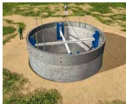
Ryc. 2. Stalowe prowadnice wysięgnika urabiającego (oznaczone kolorem niebieskim) [1]
