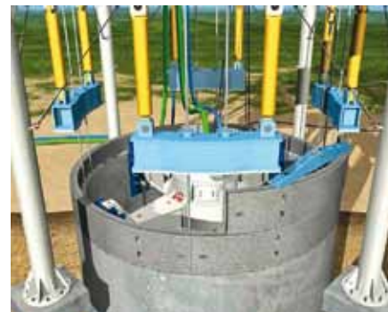
Ryc. 6. Układanie prefabrykowanych, żelbetonowych segmentów na pierścieniu początkowym [1]
