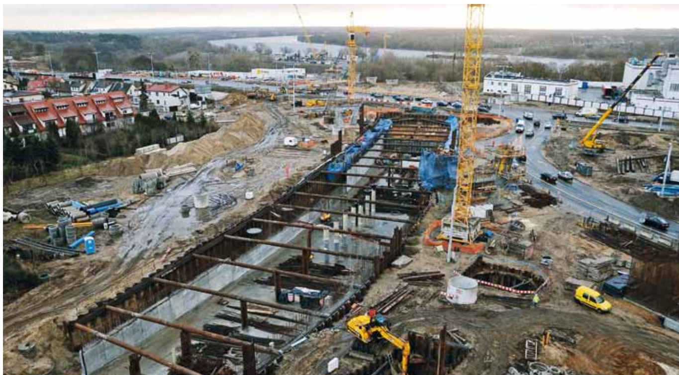
Plac Daszyńskiego – wykop podziemnego tunelu, fot. B. Kozłowski
