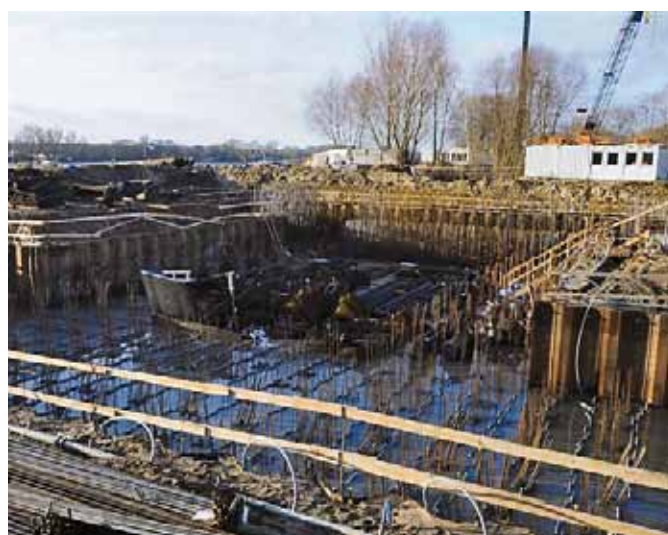
Montaż zbrojenia fundamentu podpory brzegowej mostu, fot. B. Kozłowski
