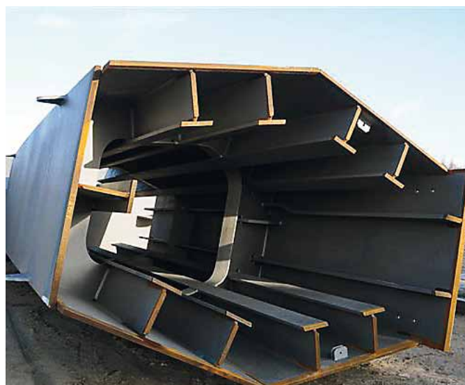
Stalowy element łuku mostu, fot. B. Kozłowski
