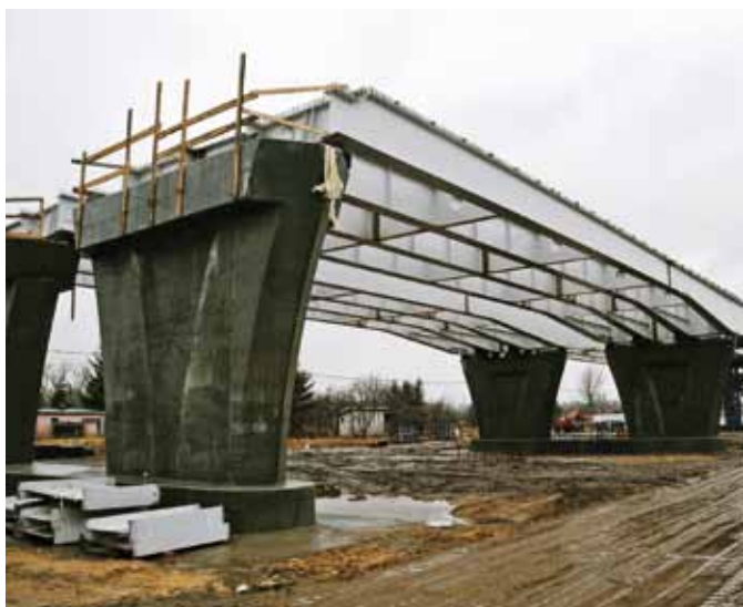
Stalowe elementy lewobrzeżnej estakady zamontowane na podporach, fot. B. Kozłowski
