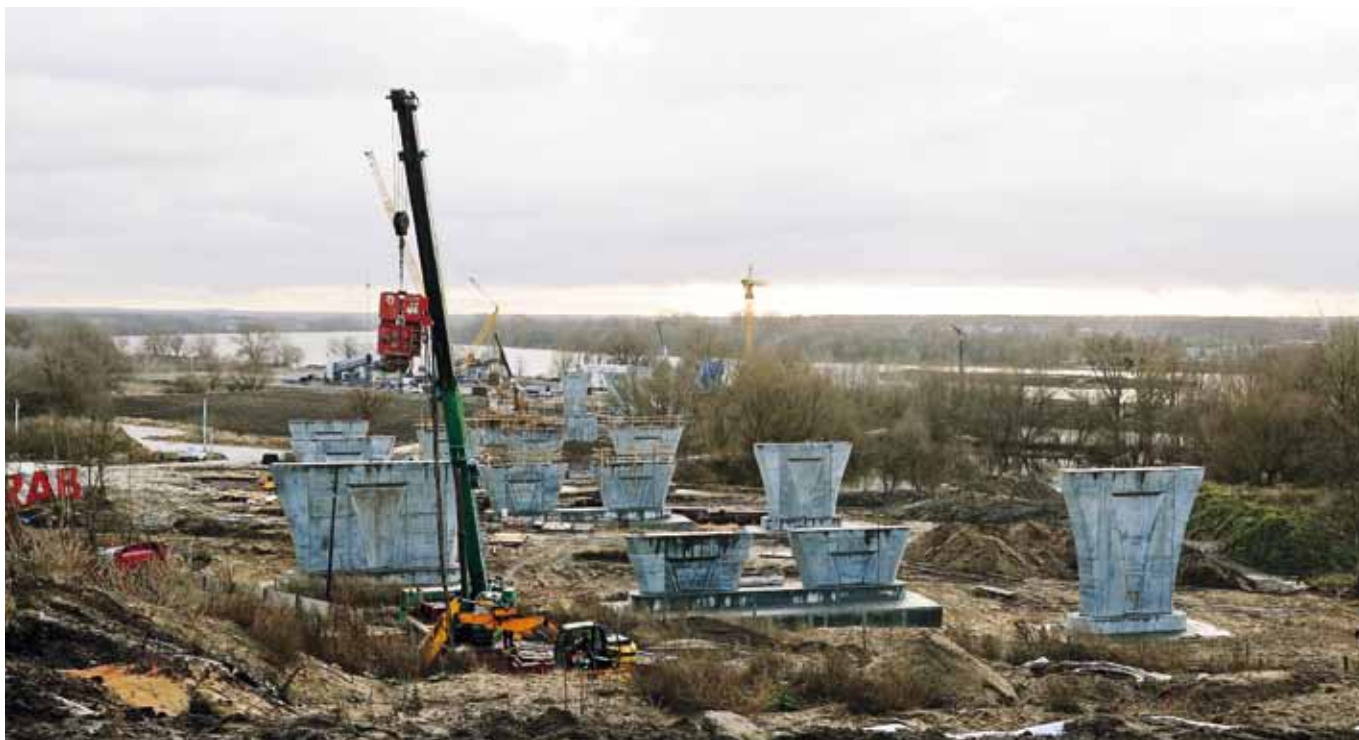
Filary podpór prawobrzeżnych estakad, fot. B. Kozłowski
