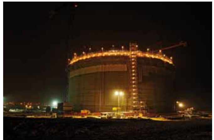
Betonowanie zbiornika TK-2011 w czasie nocnej zmiany
