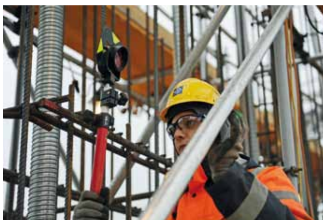
Kontrola geodezyjna deskowania ślizgowego
