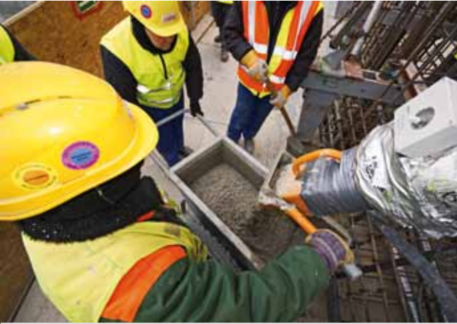
Napełnianie wózków betonem na platformie roboczej
