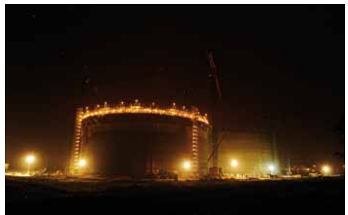
Betonowanie zbiornika TK-2011 w czasie nocnej zmiany
