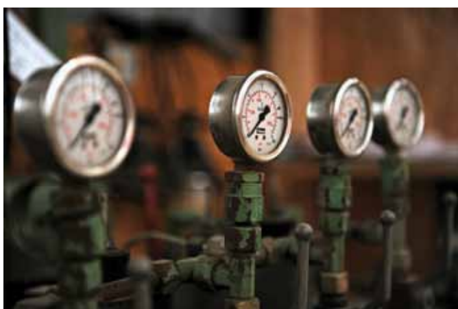
Sterownia deskowania ślizgowego
