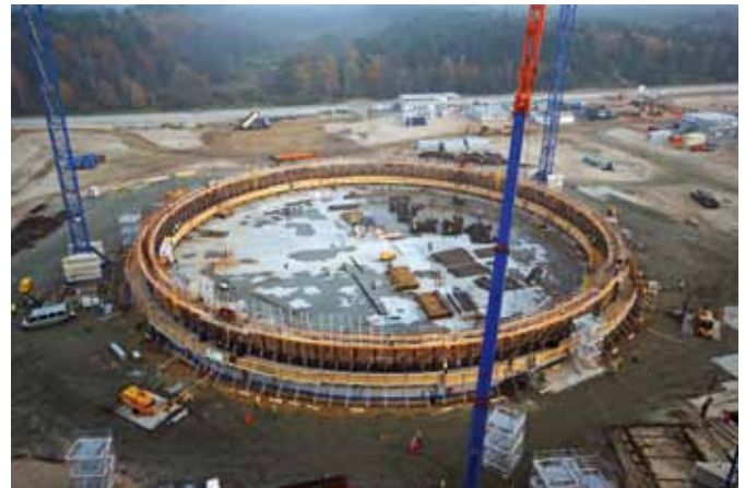
Montaż deskowania ślizgowego na zbiorniku TK-2011
