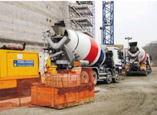
Napełnianie stacjonarnych pomp do betonu
