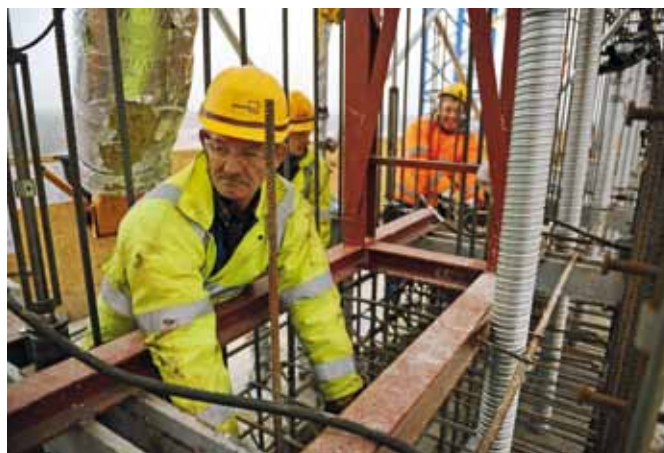
Montaż poziomych kanałów osłonowych do kabli sprężających
