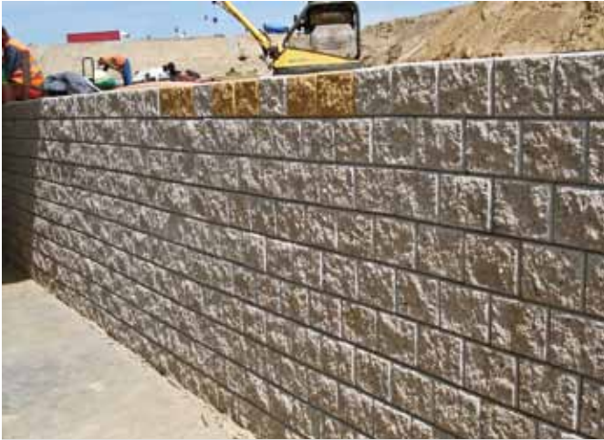
Lico ściany oporowej z bloczków ViaBlock
