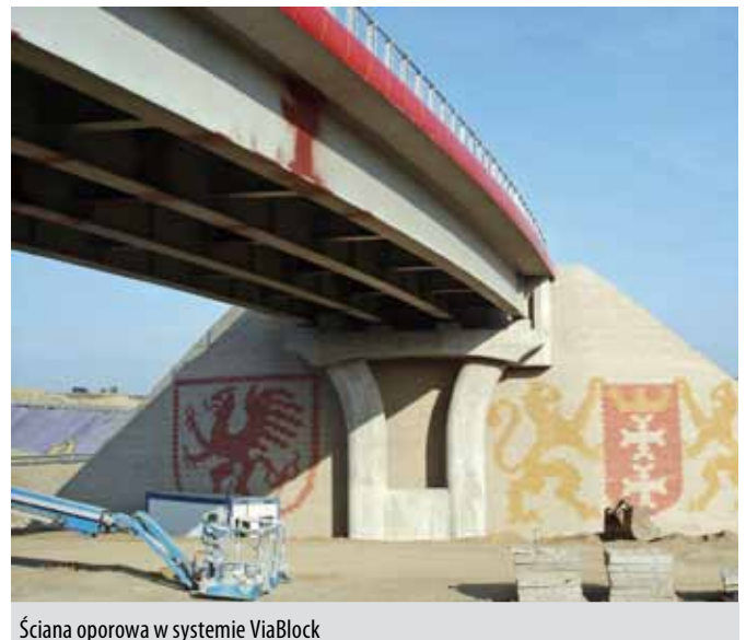
Ściana oporowa w systemie ViaBlock
