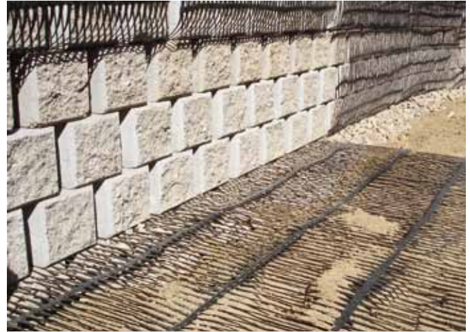
Element zbrojący z geosiatki jednokierunkowej
