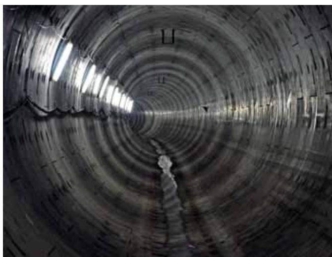
Wydrążony tunel pod Wisłą, fot. MPWiK
