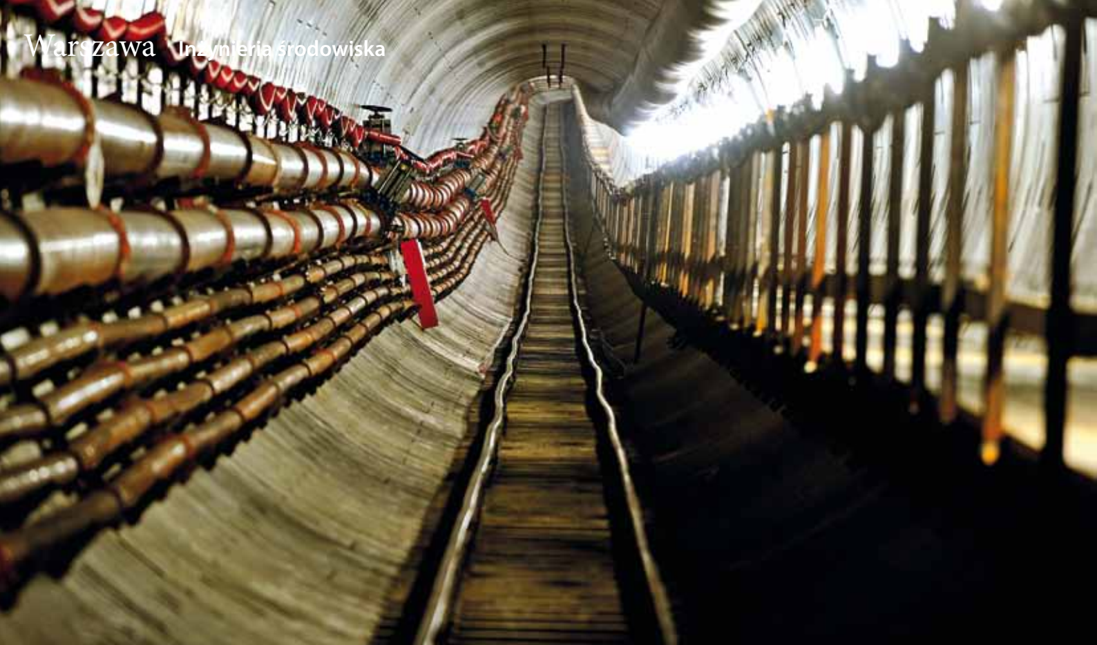
Tunel pod Wisłą w trakcie drążenia, fot. Hydrobudowa SA
