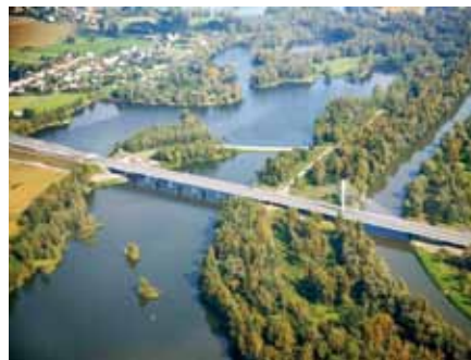
Ryc. 18. Most podwieszony przez Odrę [13]
