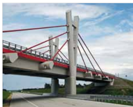
Ryc. 30. Widoki ukończonego wiaduktu WD-22 oraz konstrukcja sprężonych wsporników systemu podwieszonoego
