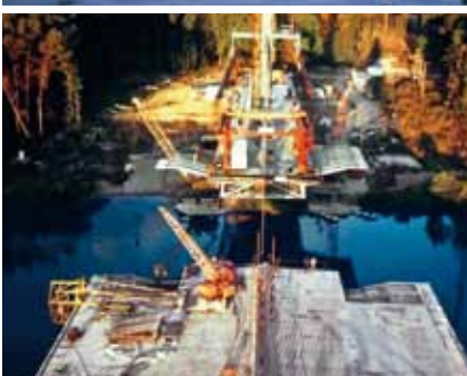
Ryc. 14. Most przez Łabę – wznoszenie konstrukcji [13]
