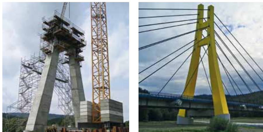
Ryc. 22. Widok mostu w Zembrzycach podczas wznoszenia i po ukończeniu
