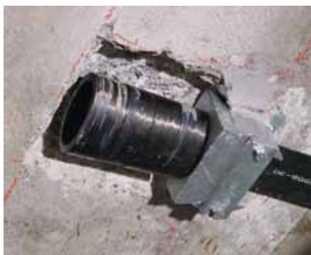
Ryc. 4. Głowica kotwiąca i stalowy blok w systemie Stress-Head (CarboDur 60 x 2,4 mm), fot. M. Łagoda
