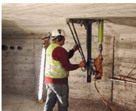
Ryc. 5. Wiercenie otworu pod stalowy blok kotwiący i urządzenie naciągowe, fot. M. Łagoda
