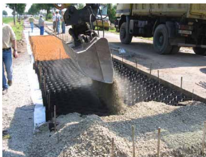
Ryc. 7. Wbudowanie geosiatki komórkowej do mineralnej warstwy nośnej drogi
