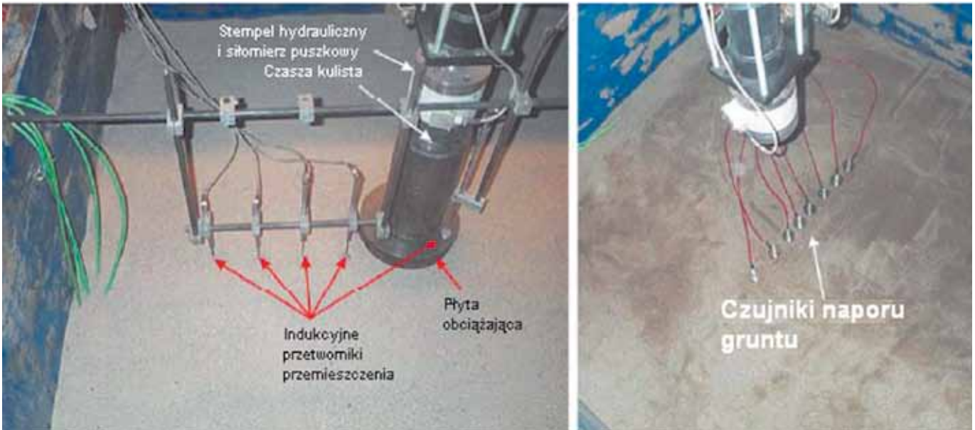
Ryc. 3. Instalacja urządzenia obciążającego z przetwornikami przemieszczenia (l) i wbudowanie czujników naporu gruntu (r)
