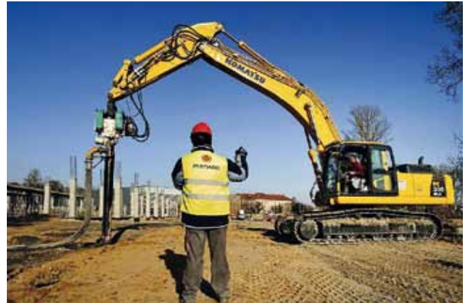
Ryc. 13. Widok maszyn do wykonywania kolumn MSC
