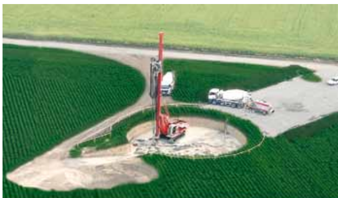
Ryc. 5. Widok wykonywania kolumn CMC pod fundamentem turbiny
