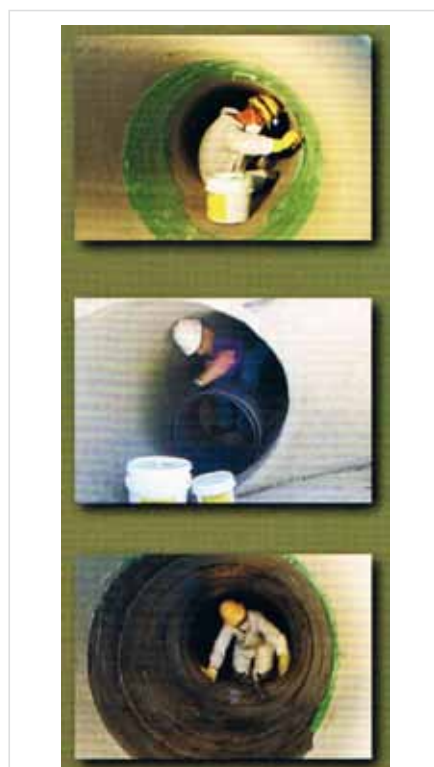
Ryc. 5. Tkaniny węglowe w odnowie przewodów kanalizacyjnych
