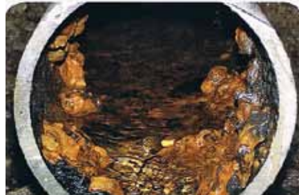
Ryc. 8. Powłoka poliuretanowa w odnowie przewodów wodociągowych
