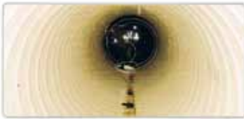
Ryc. 6. Tworzywowe tasiemki uźbierane zastosowane do renowacji kanałów przełazowych
