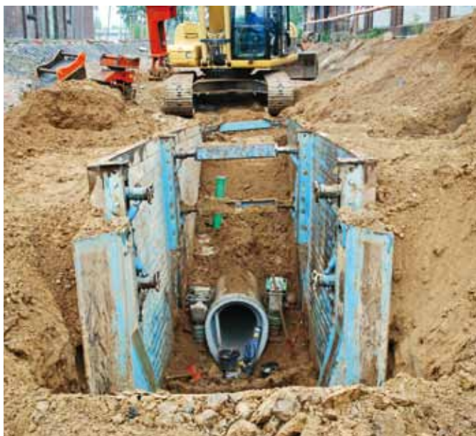
Układanie rur na odcinku 450 m
