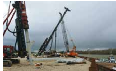
Toruń – most na Wiśle, wbijanie pali na wyspie
