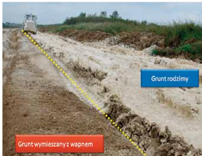
Porównanie wyglądu gruntów – rodzimego i wymieszanego z wapnem
