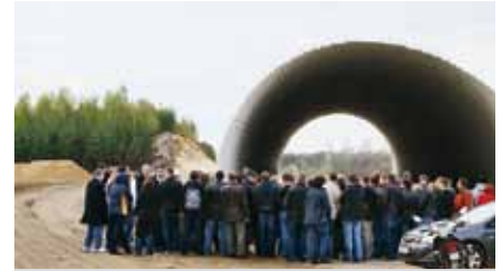
Wycieczka techniczna na budowie odcinka S5 Kaczkowo – Korzeńsko, fot. ViaCon Polska Sp. z o.o.
