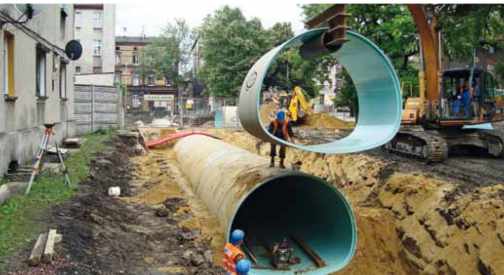
Zbiornik retencyjny z profili Amiren DN 3200/2400, Gigablok Katowice
