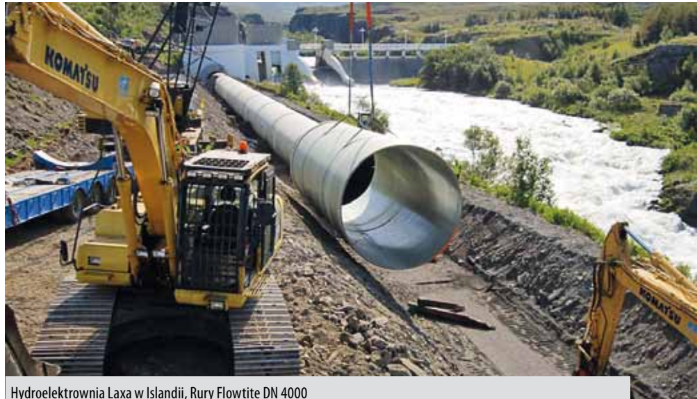
Hydroelektrownia Laxa w Islandii, Rury Flowtite DN 4000
