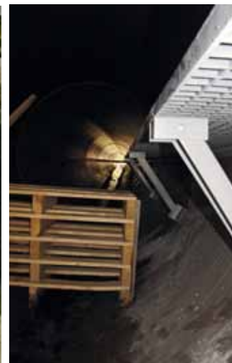
Studnia kanalizacyjna systemowa GRP/Polycrete oraz przepust GRP Flowtite DN 1600 z półkami dla migracji żab
